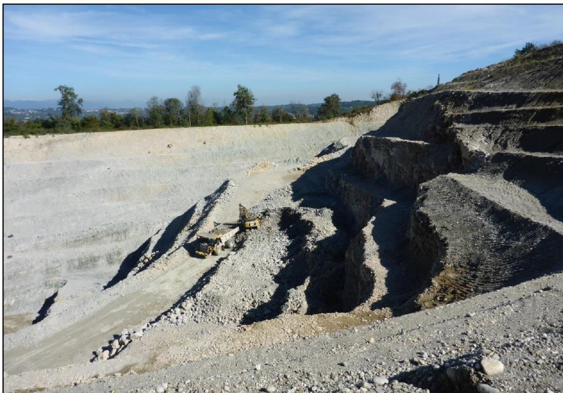
Figura 2.2 – Panoramica del fronte meridionale (Ottobre 2022)
